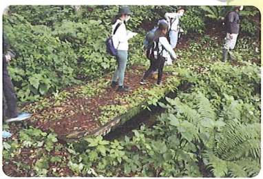
②砂防ダムにかかる小さな橋
